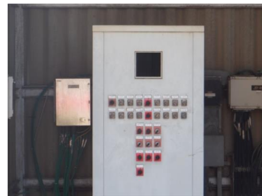
รูปที่ 2-32 ระบบหยุดสุบถ่ายฉุกเฉินทั้งระบบ บริเวณถังจัดเก็บ
