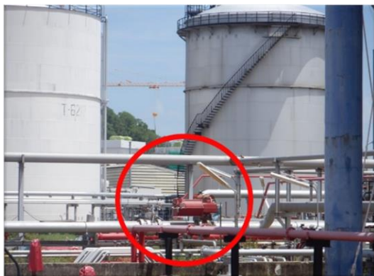
รูปที่ 2-29 วาล์วปิดทางออกฉุกเฉินสำหรับถังเก็บแก๊สปิโตรเลียมเหลว
