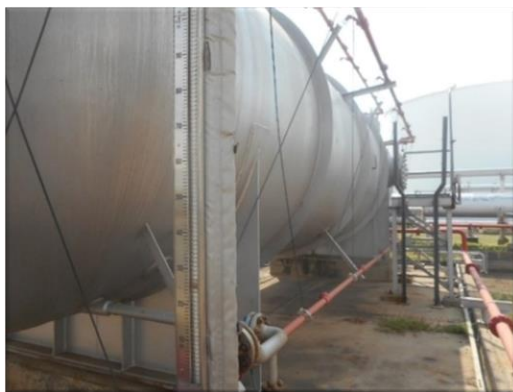
รูปที่ 2-25 Fire Detector (Plastic Tube)
