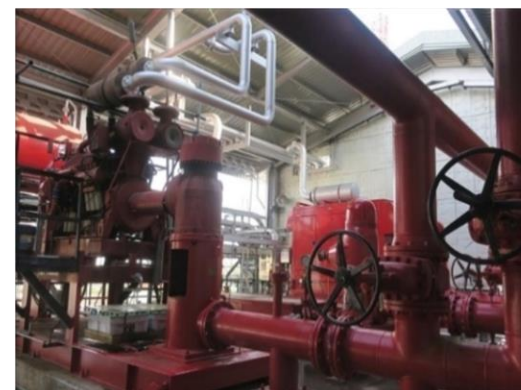
รูปที่ 2-44 บั้มน้ำดับเพลิง
