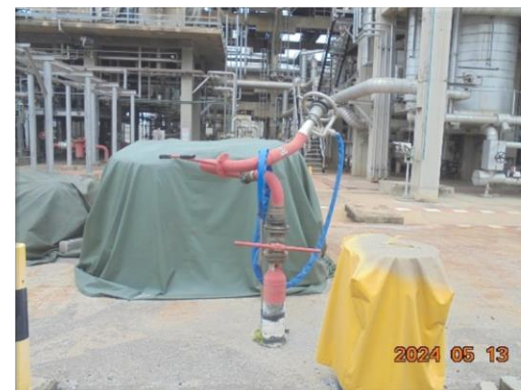
รูปที่ 2-40 หัวฉีดน้ำและโฟมดับเพลิงระยะไกล
