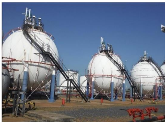
รูปที่ 2-27 ถังเก็บแก๊สปิโตรเลียมเหลว
