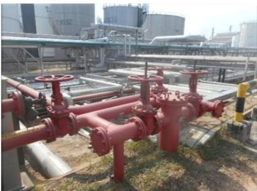
รูปที่ 2-39 วาล์วน้ำหล่อเย็นแบบเปิดด้วยมือ (Manual valve)
