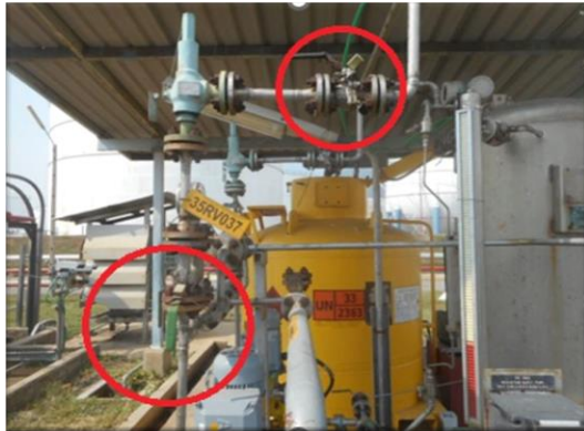
รูปที่ 2-35 Lock-out Mercaptan Injection Pump
